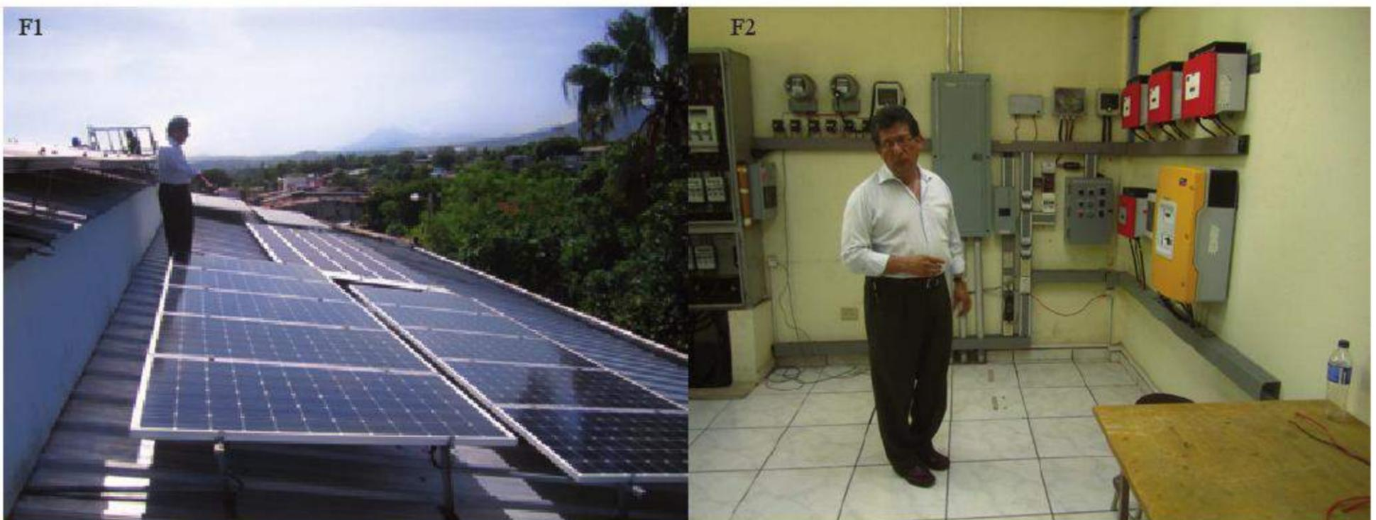
F1. Paneles solares instalados en el techo del edificio de la Escuela de Ingeniería Eléctrica. F2. Inversores de interconexión.
