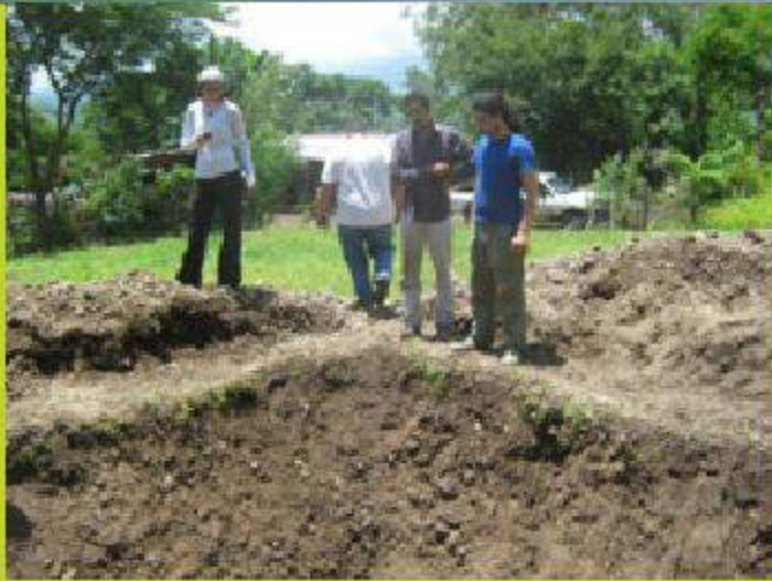
Evaluación del terreno para la construcción de estanques
