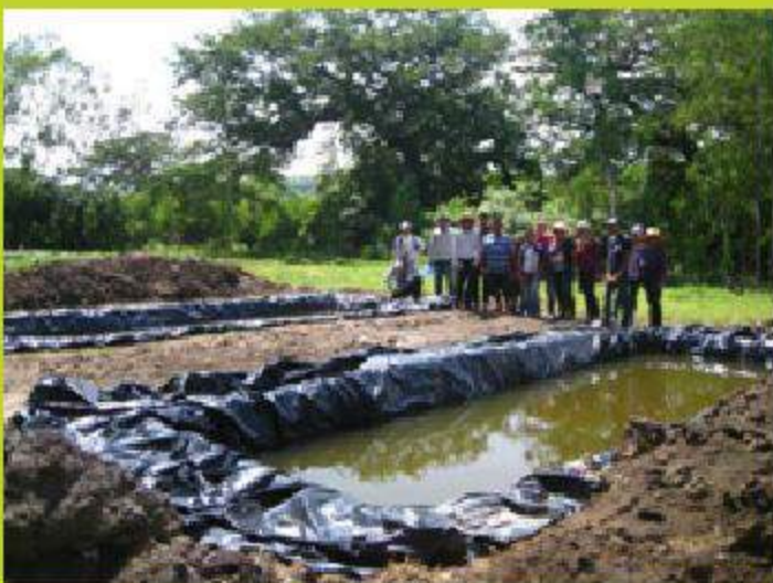
Asesoramiento de diseño, colocación de materiales y llenado de estanques.
