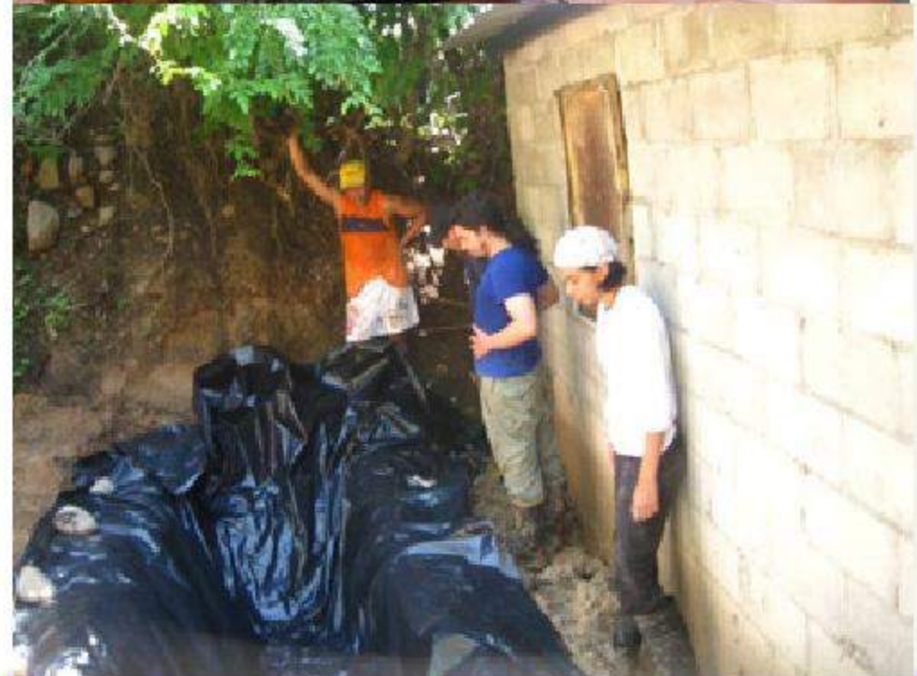
F.1. Elaboración de Almacigos en el Parque Nacional San Diego y San Felipe las Barras, F.2. Capacitación practica al grupo de estudiantes y beneficiarios sobre la construcción y mantenimiento de estanques para la piscicultura familiar.
