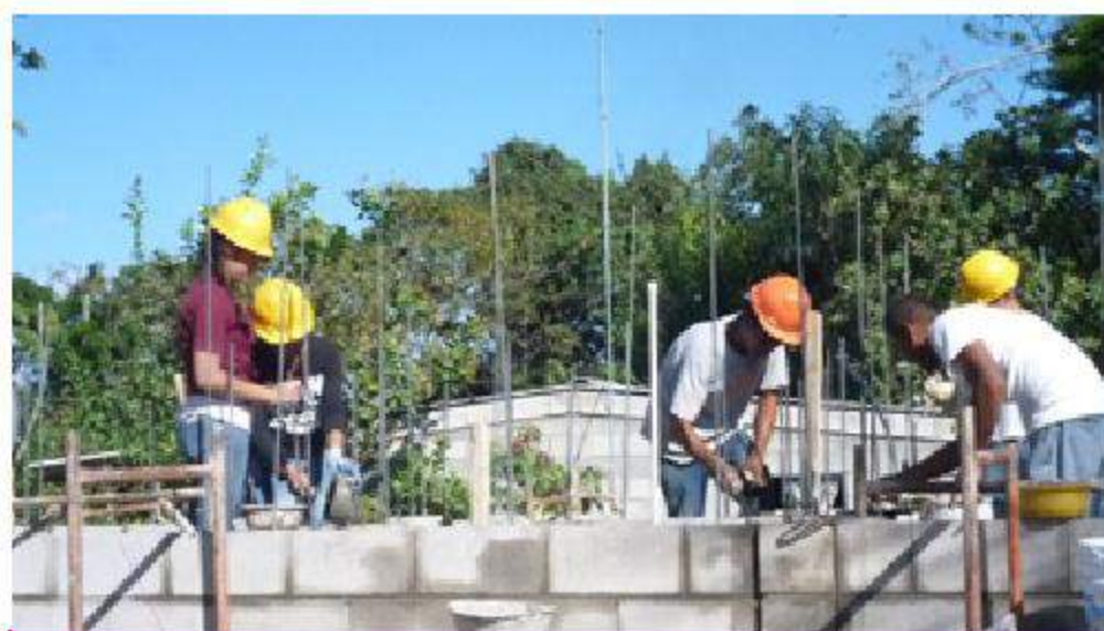
▲ Jóvenes realizan trabajos de construcción de viviendas en Amatitán.
